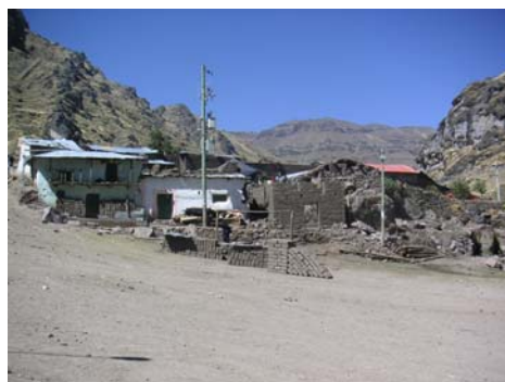
Viviendas destruidas de Chankahuasi
